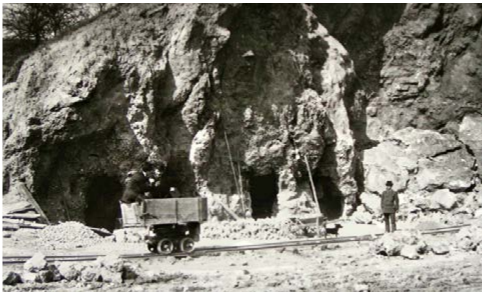
Abbildung 2: Untergrabene Abbauwand mit Sicherheitspfählen vor der Sprengung.
