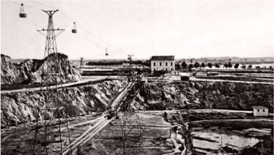
Abbildung 5: Seilbahnförderung zwischen Gipsbruch und Gipsfabrik.
