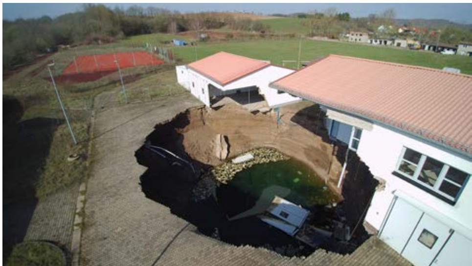
Abbildung 3: Erdfall Nordhausen. Massive Schäden an Gebäuden und Versorgungsleitungen führen zu einer Aufgabe der Gebäude.
