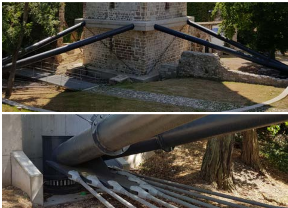
Abbildung 5: Stützkonstruktion an der Oberkirche in Bad Frankenhausen. (Fotos: UVMB)
