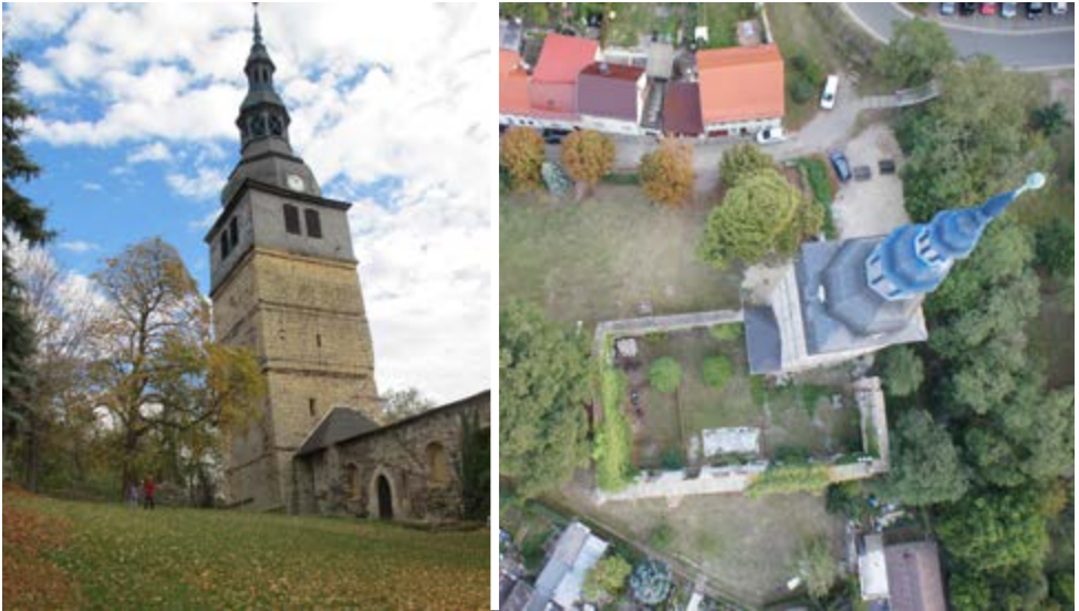
Abbildung 4: Subrosionsbedingte Schiefstellung des Kirchturms der Oberkirche in Bad Frankenhausen im Profil (links) und aus der Luft (rechts).
