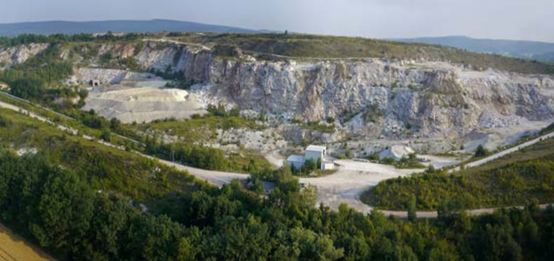
Abbildung 1: Standort Krölpa in seiner Einheit von Gips- und Anhydritgewinnung sowie der Weiterverarbeitung.
