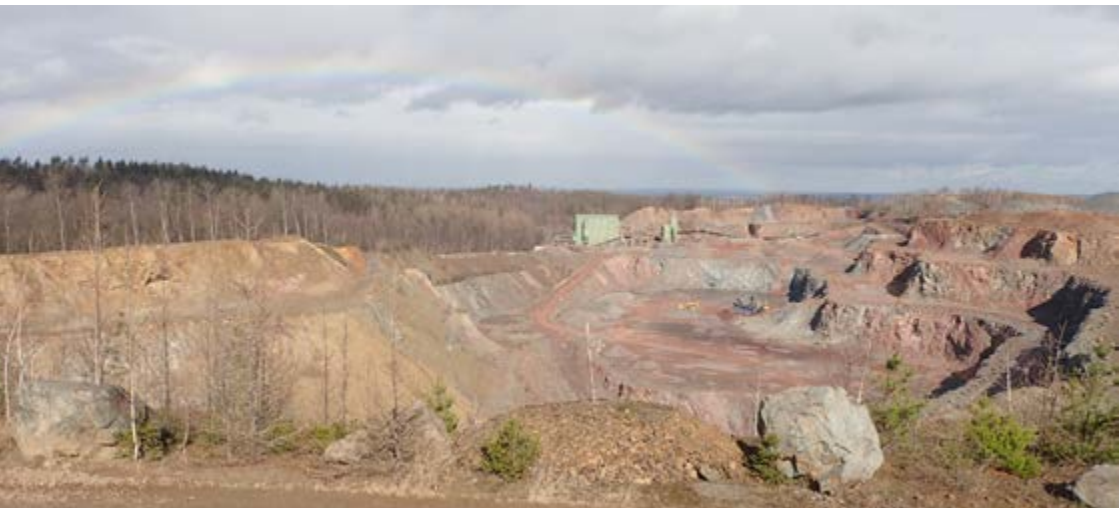
Abbildung 13: Blick in den Steinbruch Harzer Grauwacke Rieder von der südlich des Steinbruchs gelegenen Aussichtsplattform. (Foto: LAGB)
