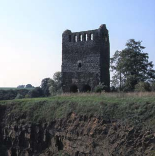
Abbildung 4: In der Kirchenruine Nordhusen wurde lokal anstehende Grauwacke (Steinbruch im Vordergrund!) im Bruchsteinmauerwerk verbaut. (Foto: H. Siedel)
