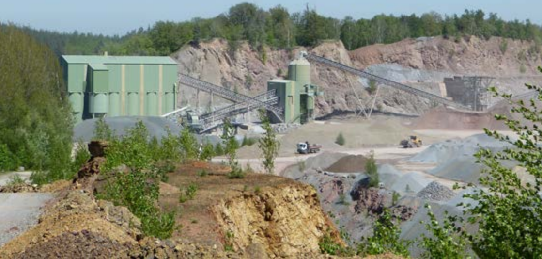
Abbildung 7: Stationäre Aufbereitungsanlage: Ziel der Aufbereitung ist die Erzeugung einer möglichst kubischen Kornform. Um dies zu erreichen, besteht die Möglichkeit das Material mehrfach zu brechen.
