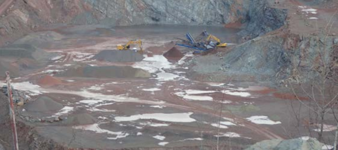
Abbildung 14: Detailblick in den Steinbruch Harzer Grauwacke Rieder nach Süden. (Foto: LAGB)
