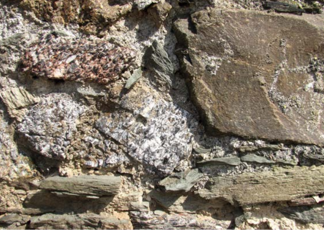
Abbildung 8: Neoproterozoische Grauwacke der Weesenstein-Gruppe (teilweise konglomeratisch) im Bruchsteinmauerwerk in Burkhardswalde im Elbtalschiefergebirge. (Foto: H. Siedel)
