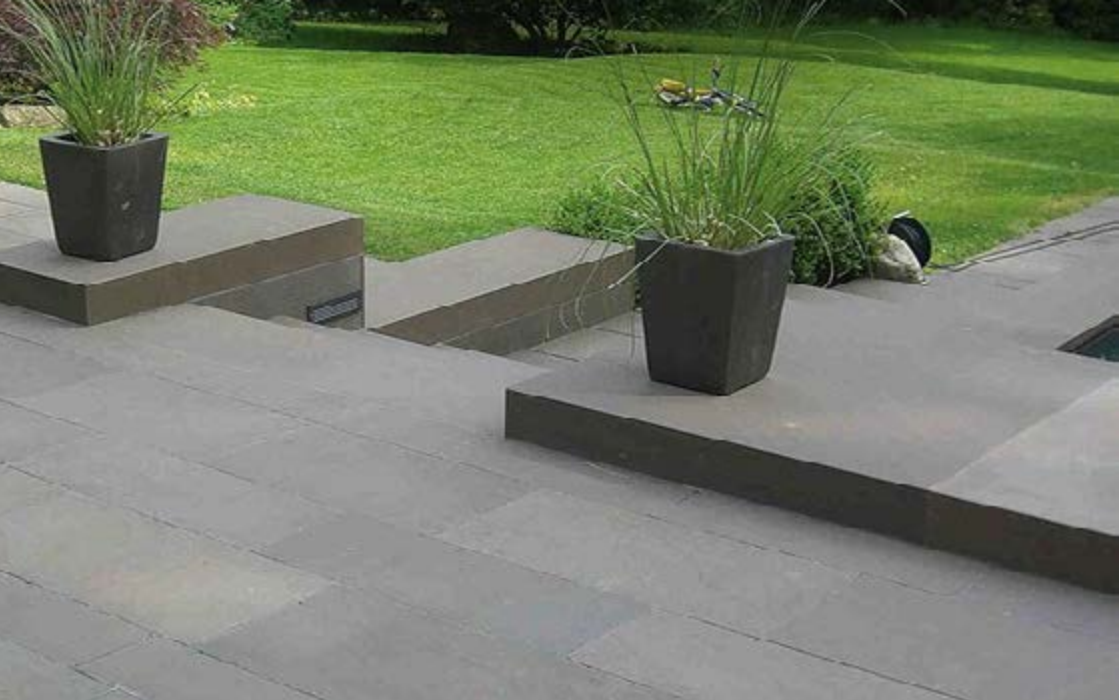
Abbildung 3: Einsatz von Grauwacke als Naturwerksteinanwendung in Form von Terrassenplatten. (Foto: Wolfgang Reimer)
