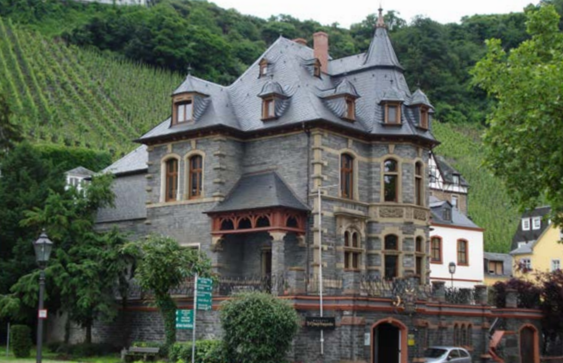
Abbildung 10: Repräsentatives Gebäude in Bernkastel-Kues mit „Moselgrauwacke“ als Baugestein im Fassadenmauerwerk. (Foto: F. Häfner)
