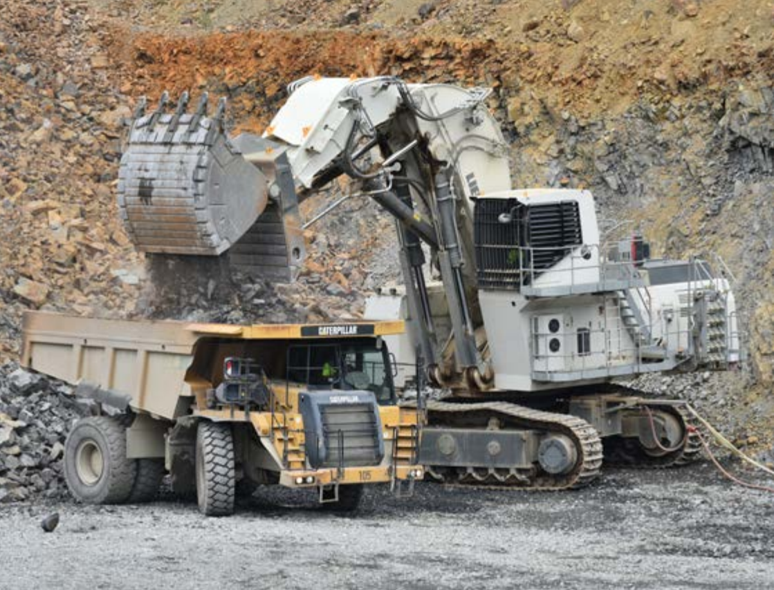
Abbildung 3: Verladung des gesprengten Haufwerkes mit Bagger auf SKW.
