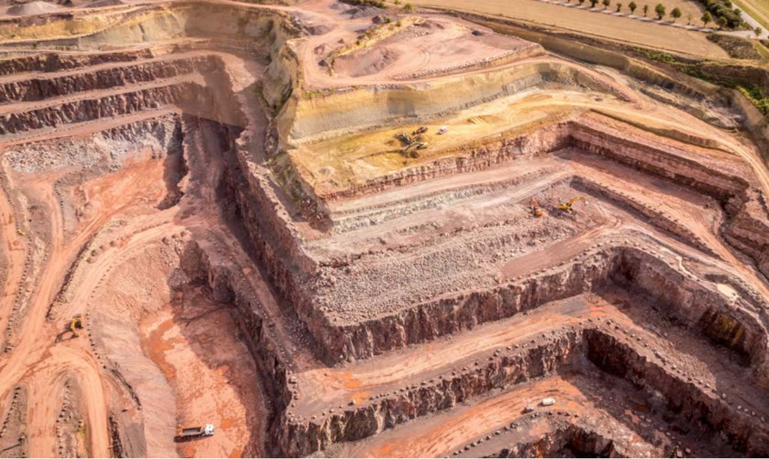
Abbildung 3: Blick in die Süderweiterung mit mächtiger Überlagerung des Andesits durch verschiedene Sedimentgesteine.
