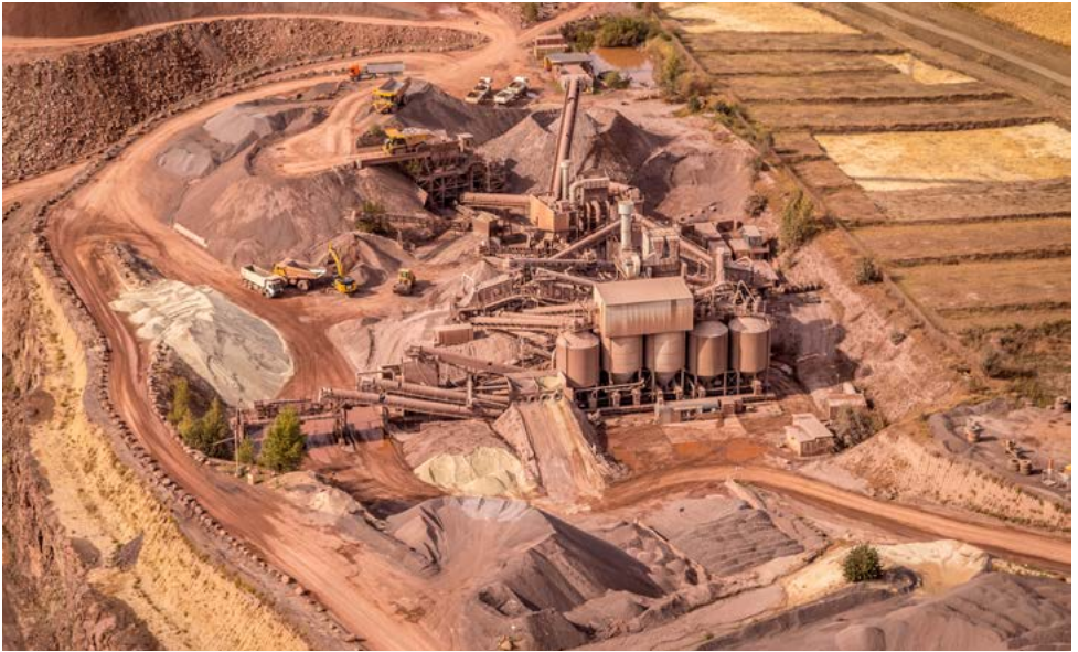
Abbildung 6: Aufbereitungsanlage mit Materiallagern am Rande des Gewinnungsbetriebes.
