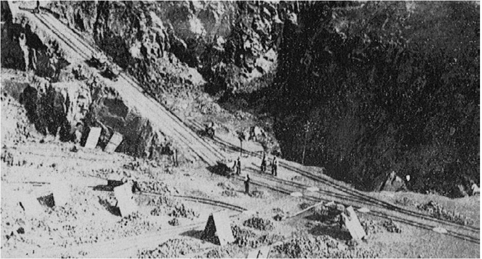
Abbildung 12: Steinbruch Kuckucksberg bei Bebertal (Dönstedt) ca. 1925 (Quelle: Zuschlagstoffe Haldensleben).
