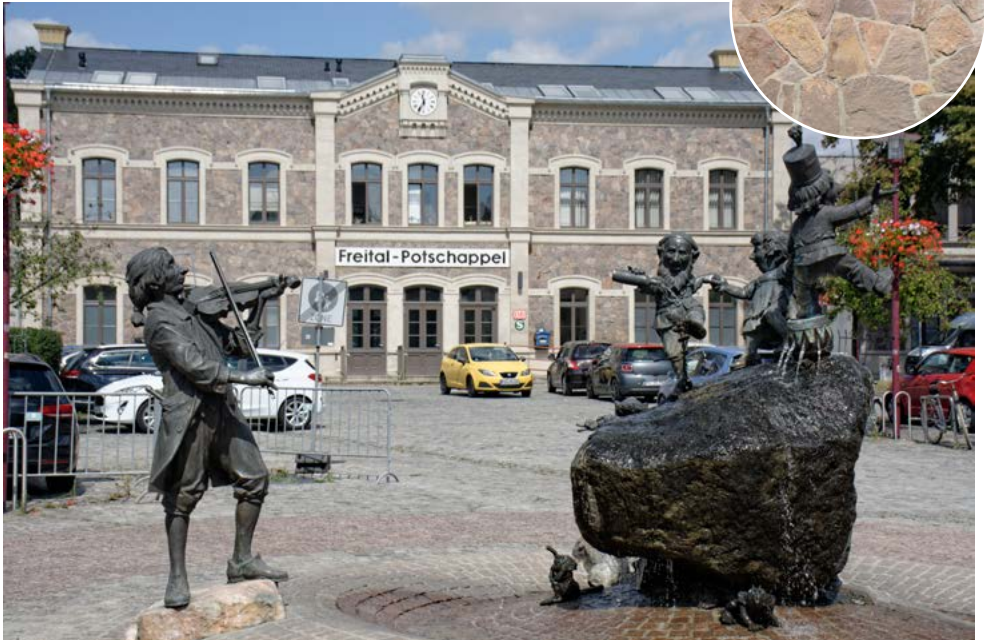
Abbildung 15: Der Bahnhofsvorplatz von Freital-Potschappel wurde nach Abriss mehrerer Gebäude neu gestaltet. Im Hintergrund Bahnhofsgebäude Freital-Potschappel aus rötlichem Porphyrit. Detailausschnitt zur Natursteinverwendung am Bahnhofsgebäude (Foto: UVMB/Dittrich 2020).
