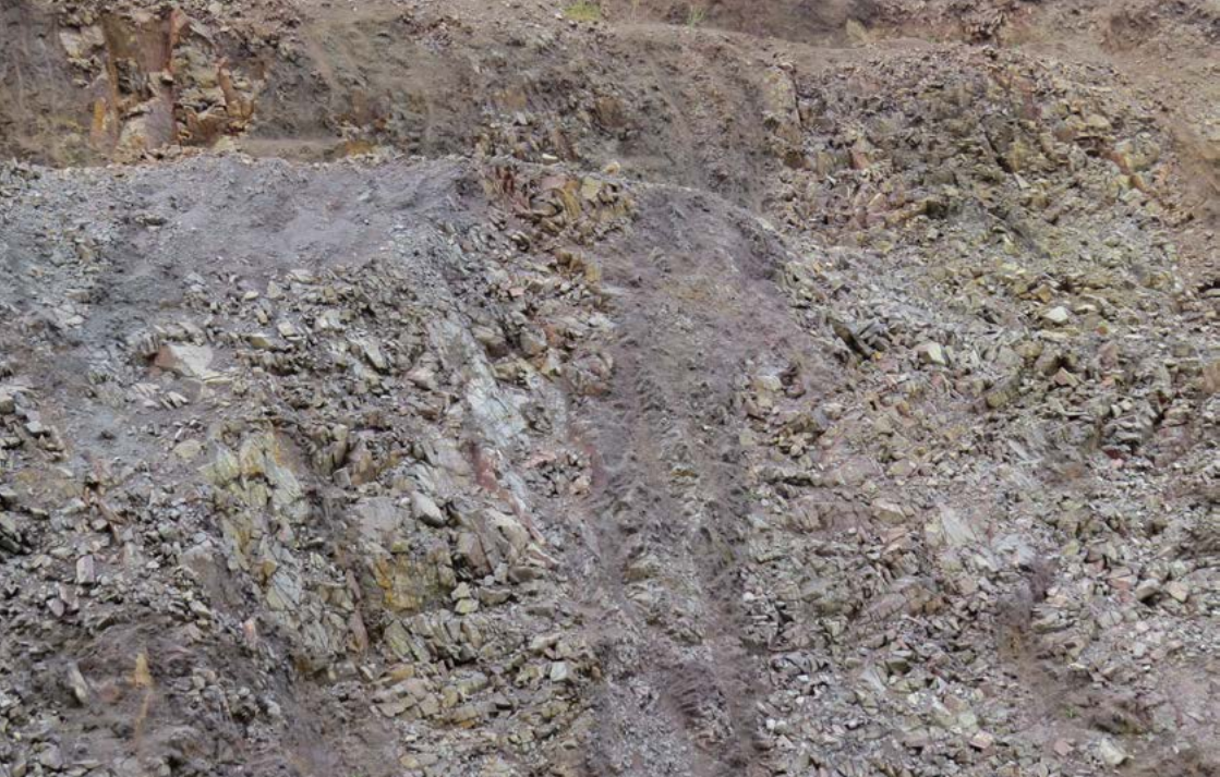
Abbildung 5: Festigkeitsgemindertes Gestein im Bereich von Störungszone im Steinbruch Wurgwitz (Aufschlussverhältnisse Oktober 2017) (Foto: Rainer Brauer).
