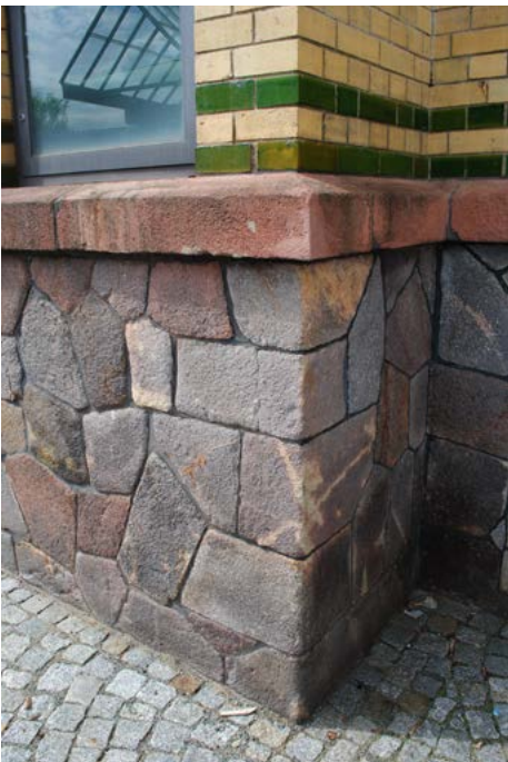
Abbildung 9: Altenburger „Porphyrit“ im Sockelmauerwerk eines Gebäudes in Zwickau (Sims aus Rochlitzer Porphyrtuff).
