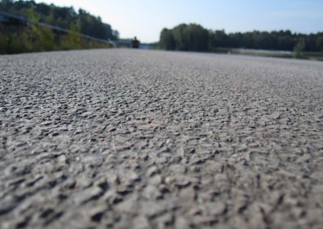
Abbildung 9: Neu hergestellte Waschbetonoberfläche auf der BAB 11.
