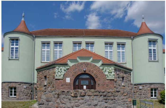
Abbildung 14: Turnhalle am Sauberg in Freital-Potschappel, erbaut 1926 aus Porphyrit (Foto: UVMB 2020).
