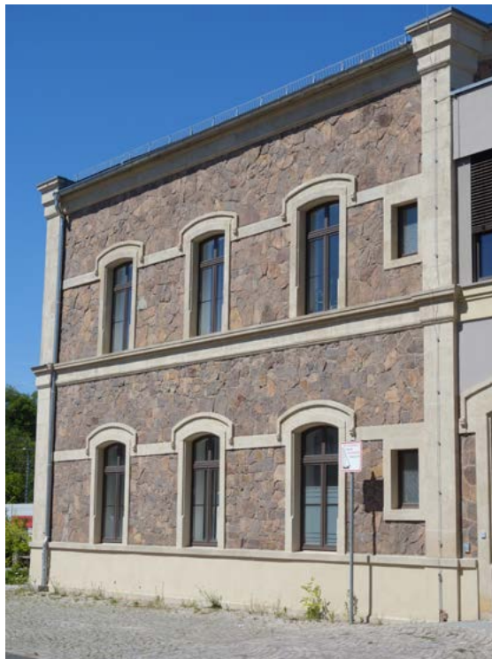
Abbildung 10: Seitenflügel des Bahnhofsgebäudes von 1855 in Freital-Potschappel, an dem „Porphyrit“ in unregelmäßigem Sichtmauerwerk im Verbund mit Fenstergewänden und Gliederungselementen aus Elbsandstein verbaut wurde.
