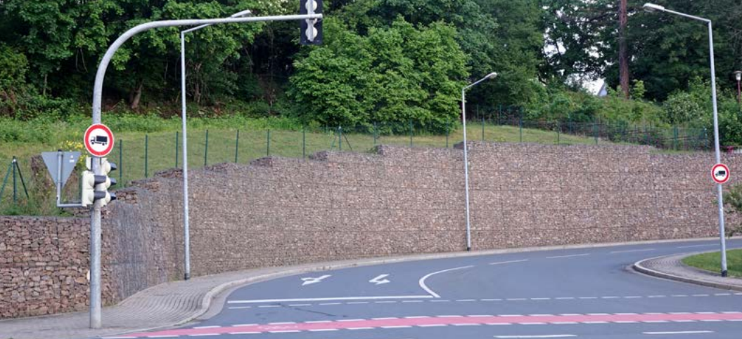
Abbildung 19: Bis über fünf Meter hohe Gabionenwand aus Porphyrit in Freital, Hüttenstraße/Einmündung Schachtstraße (Foto: Dittrich 2020).
