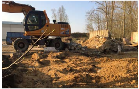
Abbildung 10: Rückbau einer ehemaligen, durch Beton befestigten und versiegelten Lagerfläche.
