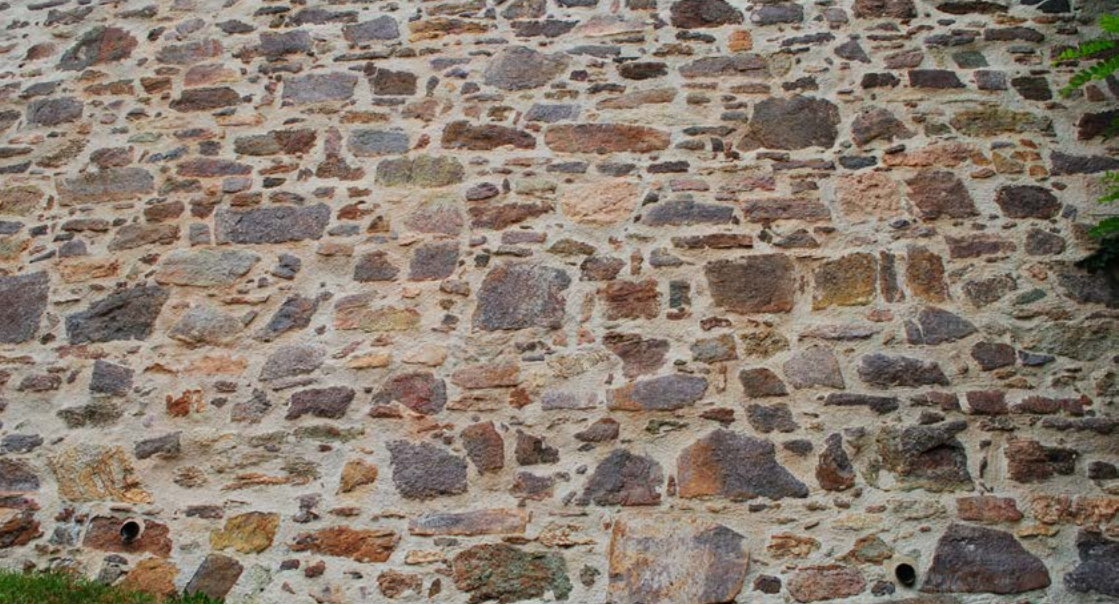
Abbildung 8: Bruchsteinmauerwerk aus dem im Untergrund anstehenden Biotit-Phänoandesit („Porphyrit“) am Schloss Altenburg.
